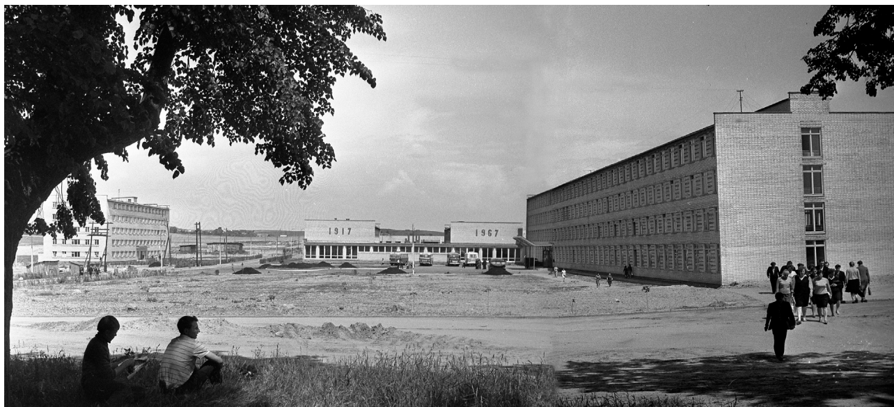
Новый корпус ГСХИ, 1967 г.
